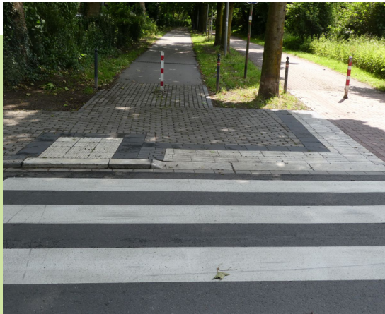
Bild 21: Barrierefreier Zebrastreifen: 6cm mit Aufmerksamkeitsfeld, 0cm mit Sperrfeld
