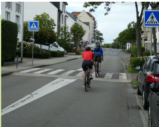
Bild 22: Teilaufpflasterung des Zebrastreifens
