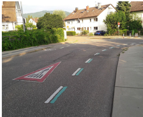
Bild 16: Hier wurde das Gefahrzeichen (zusätzlich) auf die Fahrbahn gemalt, weil der Zebrastreifen hinter einer Kurve liegt.
