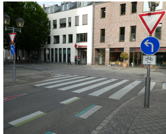
Bild 17: Muss der Fahrverkehr sowieso warten, braucht es keinen Hinweis auf einen Zebrastreifen.
