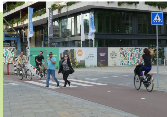
Bild 8: Zebrastreifen über Radwege: links eine deutsche Lösung mit Schilderwald und Warnleuchten, rechts eine einfachere niederländische Lösung
