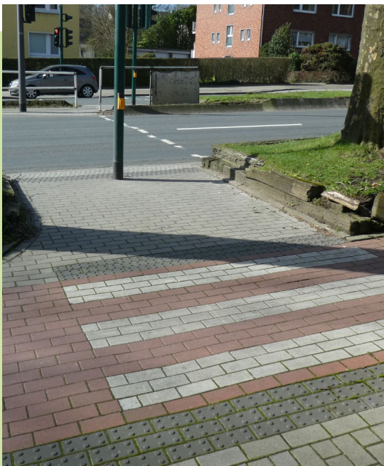
Bild 3: Zebrastreifen über den nicht signalisierten Radweg an einer Fußgängerampel
