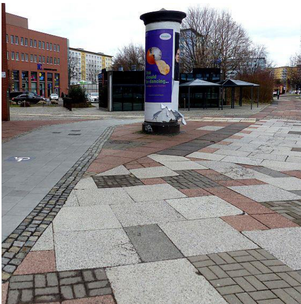
Nordwestlicher Gehweg in der Theaterstraße. Links im Foto der im Foto oben gezeigte neu eingefügte barrierefreie Wegeabschnitt.
