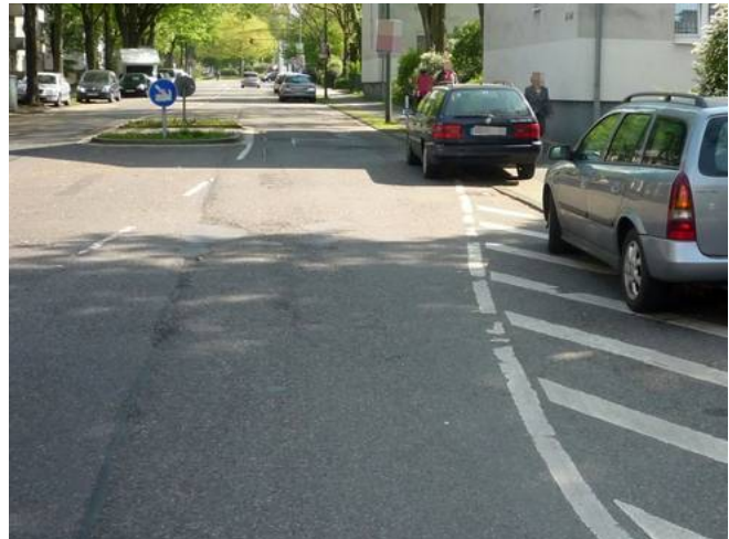
Bild 15: Vor diesem Übergang mit Mittelinsel kann nicht geparkt werden, ohne verbotenerweise Gehweg oder Sperrfläche zu nutzen.
