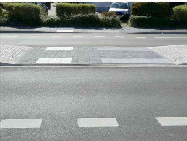
Bild 2: Abgesenkte Bordsteine erleichtern die Straßenquerung.
