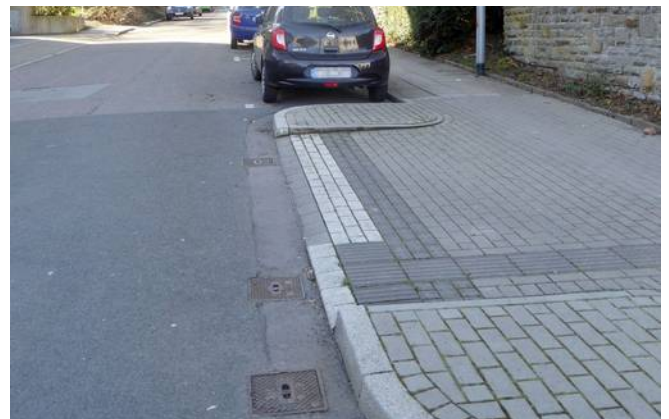
Bild 21: Gehwegvorstreckungen verhindern, dass vor und auf Querungsstellen geparkt wird.
