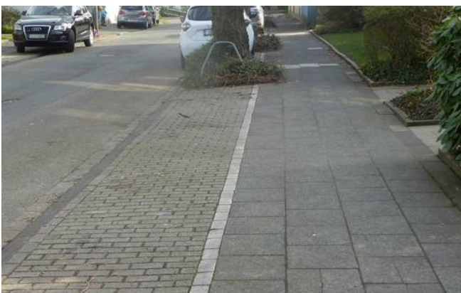
Bild 69: Gefordert ist eine kontrastierende Linie, welche die Parkfläche begrenzt.
