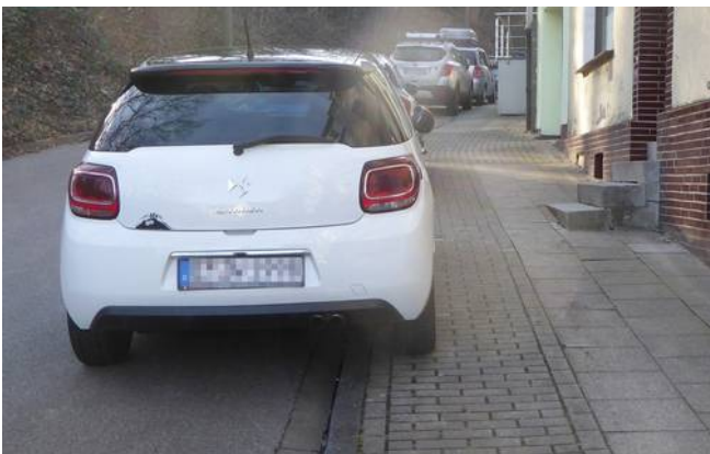
Bild 68: Abgesenkte Bordsteine und eine kleinteilige Pflasterung laden zum Falschparken ein. Sie stellen aber keinen Parkstreifen dar.
