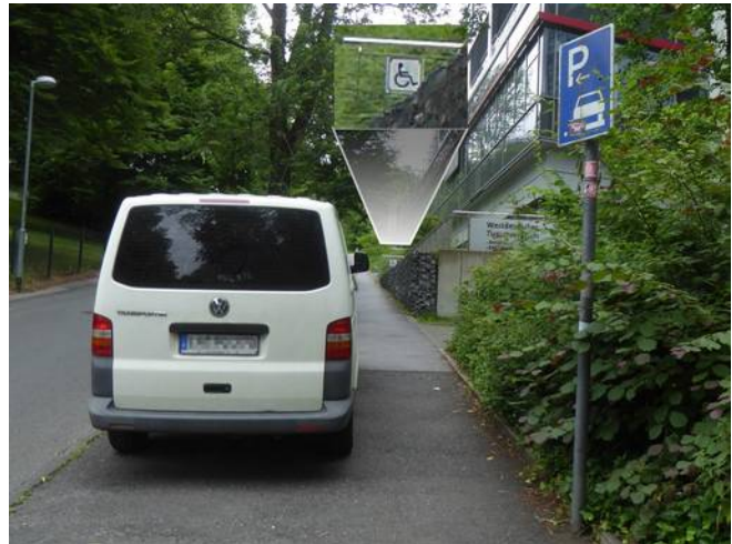
Bild 75: Dieser extrem schmale Restgehweg zu einem barrierefreien Eingang widerspricht allen Vorschriften.
