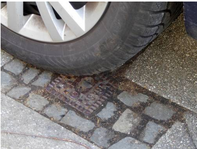
Bild 17: Im Gehweg liegen Zugänge zu Gas- und Wasserleitungen.
