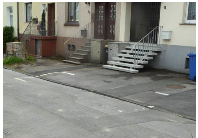
Bild 83: Wird beim Aufheben der Sonderparkfläche die Parkmarkierung gelassen, ist Gehwegparken an dieser Stelle erlaubt.
