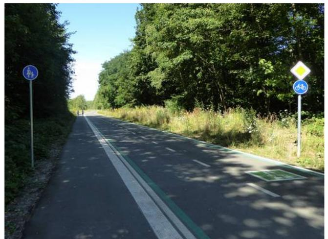
Bild 95: Radschnellweg und Gehweg durch optisch und taktil gut wahrnehmbaren Sicherheitsstreifen getrennt
