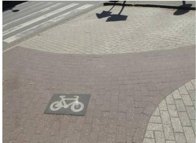
Bild 55: Kennzeichnung des Radwegs mit Fahrradpiktogramm
