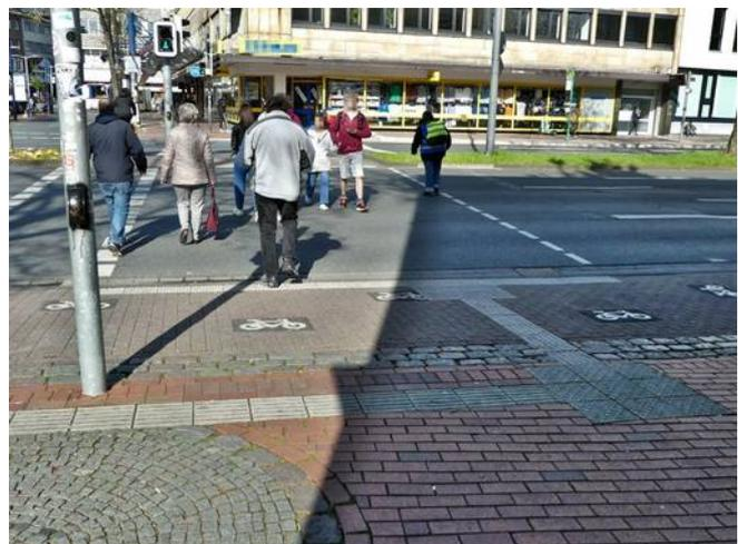
Bild 100: Führung des Radwegs am Fahrbahnrand mit ausreichender und barrierefrei gestalteter Wartefläche
