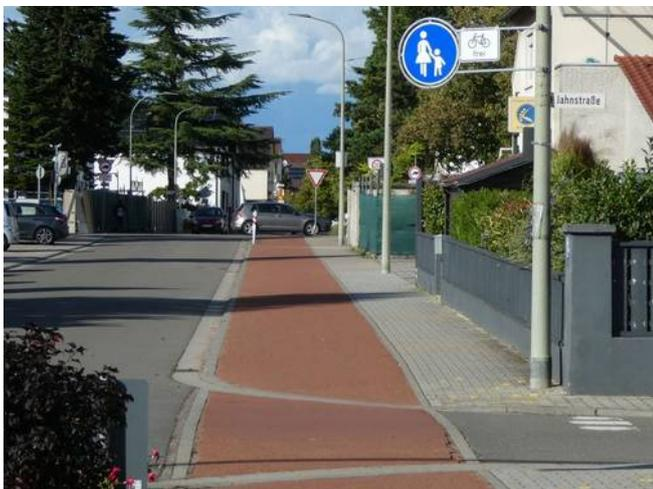
Bild 60: Dass dies kein Radweg mehr ist, erschließt sich nur durch das Verkehrszeichen.
