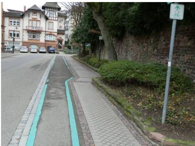
Bild 46: Hier entspricht weder der Radweg noch der Gehweg den Mindestbreiten.
