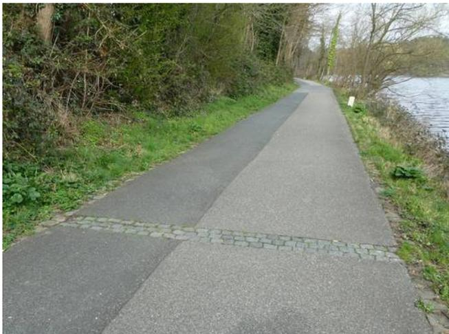
Bild 82: Aufwändig, aber effektiv ist es, schnelle Radfahrer durch unkomfortable „Bremsschwellen“ zu langsamerem Tempo zu animieren.
