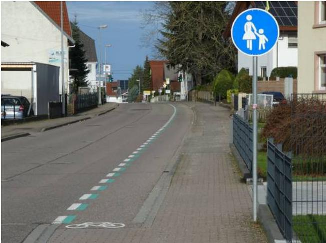
Bild 21: Die Gehwegfreigabe endet, Radverkehr muss auf die Fahrbahn, hier mit Schutzstreifen.
