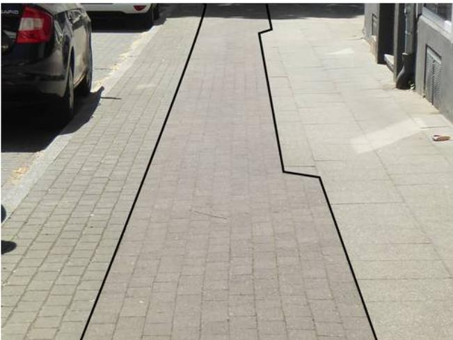
*Bild 52: Nicht benutzungspflichtiger, viel zu schmaler Radweg zwischen Sicherheitsstreifen und Gehweg – Die kaum erkennbaren Pflasterunterschiede wurden im Bild verdeutlicht (schwarze Linien).*
