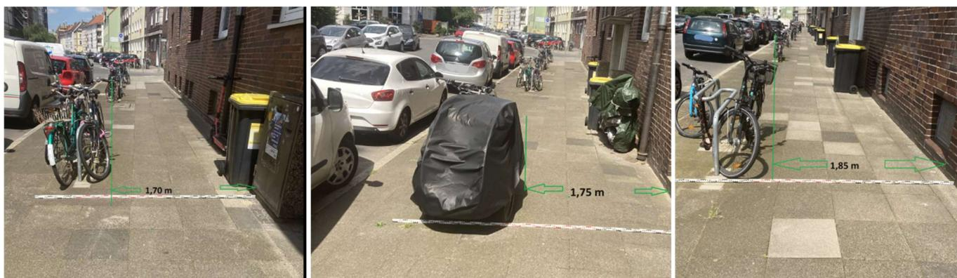
**Bilder 14, 15, 16:** Fahrradbügel auf dem Gehweg östliche Seite. Die Restgehwegbreite beträgt zwischen 1,70 m und 1,85 m. 2,20 m sind in dem Fall das Mindestmaß. Siehe auch Bild 18.
