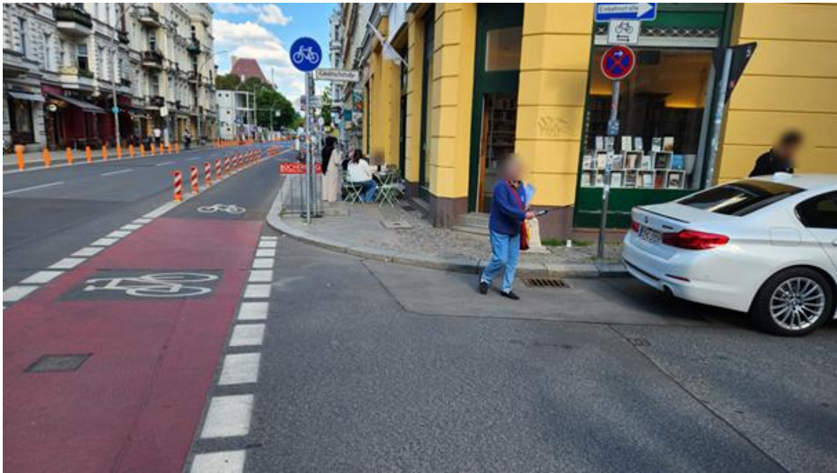
Gleditschstraße • auf der einen Seite ist der Gehweg abgesenkt; was nutzt es, wenn auf der anderen Seite keine Absenkung da ist
