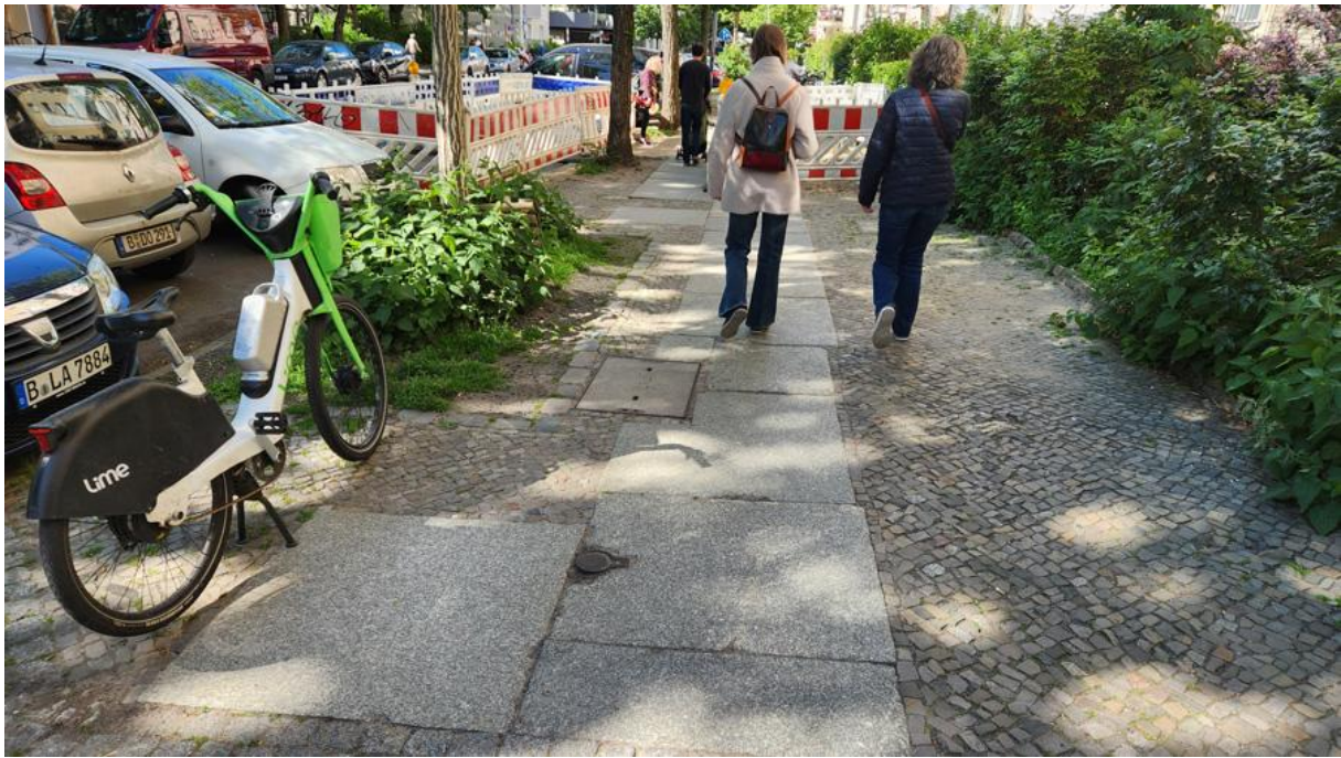
Die Gehwegbreite wird immer wieder durch Baumscheiben eingeengt / Schweinebäuche sind ein suboptimaler Gehwegbelag
