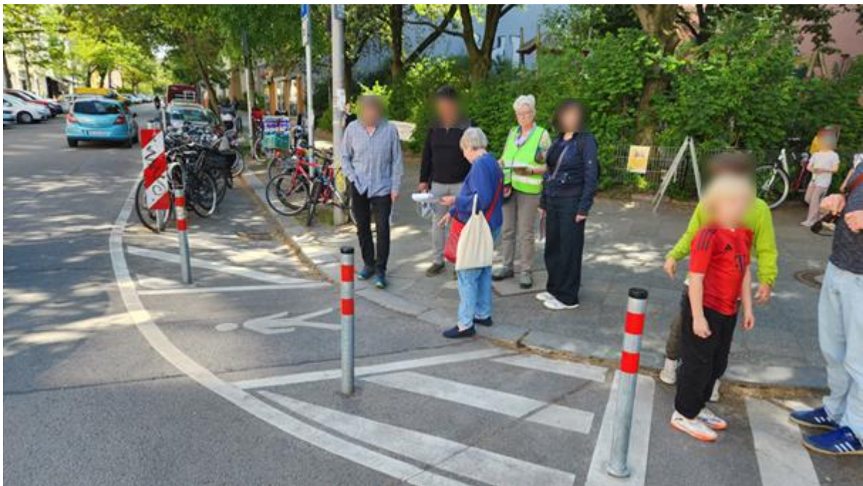
Barbarossastraße / Goltzstraße • Beurteilung der Absenkung / Neu ist die Gehwegvorstreckung
