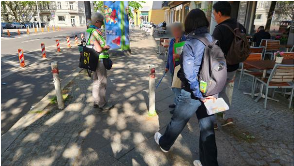
Behindernder Gehwegpoller mitten in der Gehwegbahn
