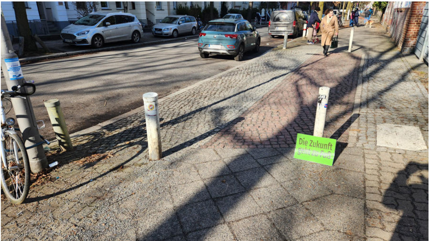
Naumannstraße Naumannpark Haus 1 • Behindernde Gehwegpoller
