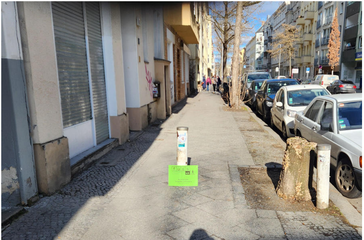
Leberstraße 48 • Behindernde Gehwegpoller
